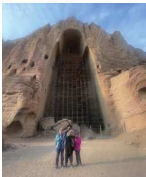
圖41 東大佛洞搭起鷹架 整修。
